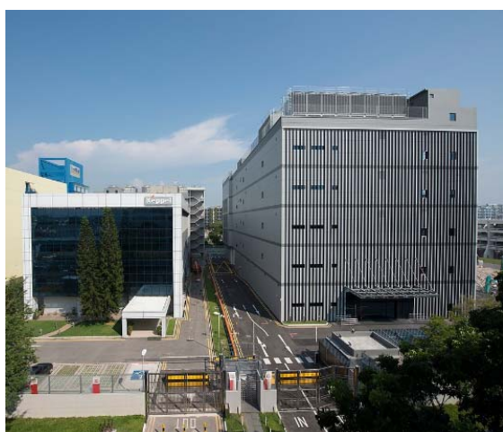
Keppel Datahub and Keppel Datahub 2, Singapore
