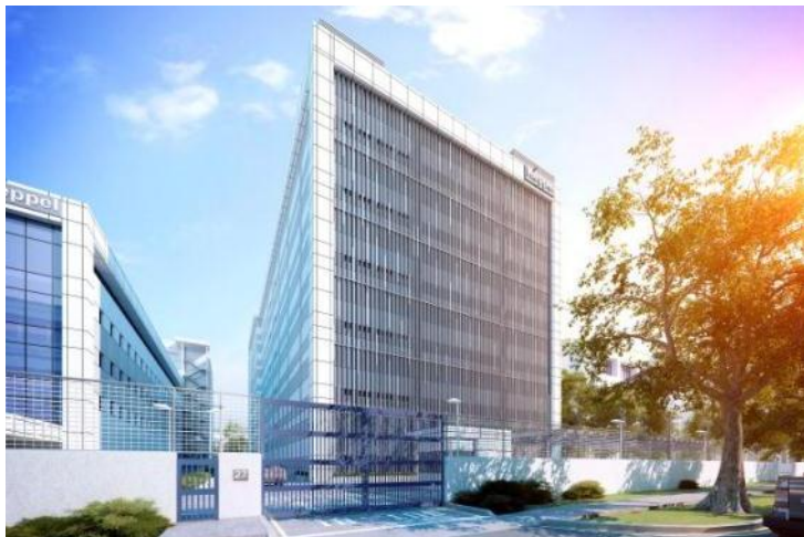
Keppel Datahub 2, Singapore
